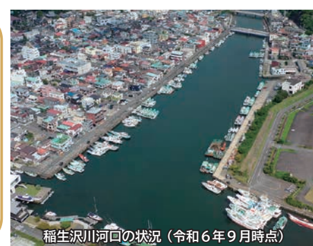
稲生沢川河口の状況（令和6年9月時点）
