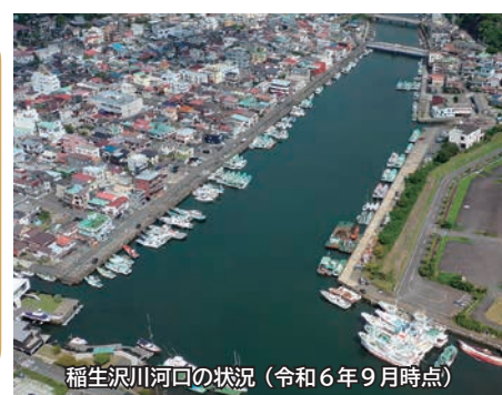
稲生沢川河口の状況（令和6年9月時点）
