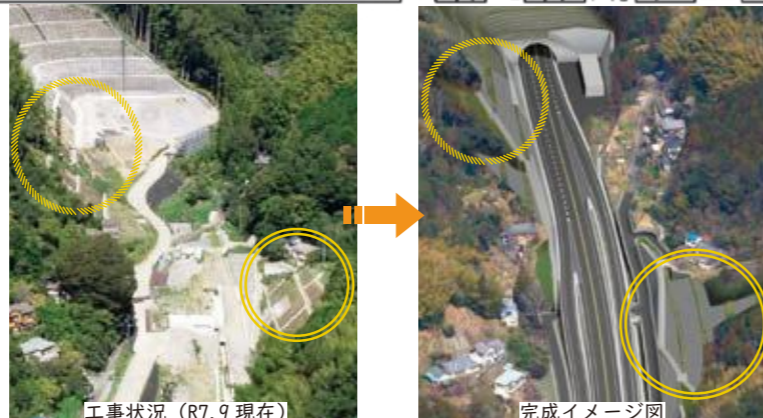
工事状況（R7.9現在）
