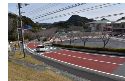
新中学校付近のカラー舗装
