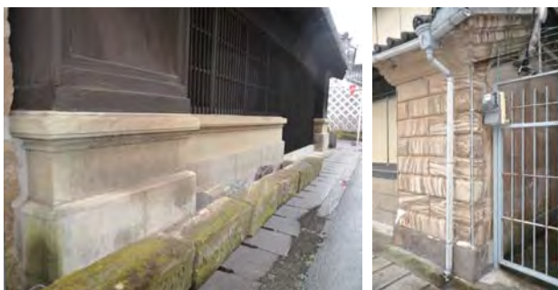
美しく仕上げられた腰壁
