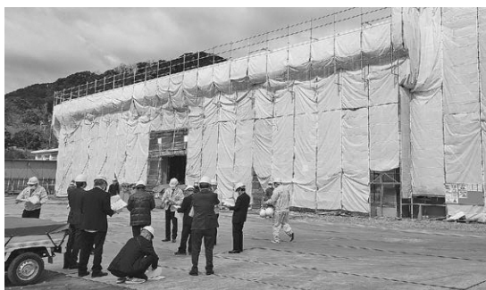
下田中学校整備工事（新屋内運動場）
