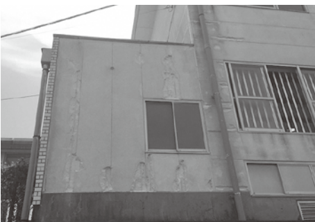
浜崎小学校屋内運動場外壁
