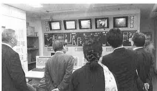
広域清掃センター中央制御室見学
