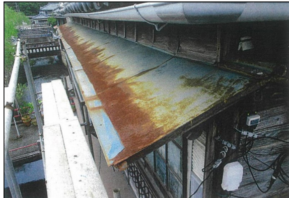
登録番号No.5土佐屋(屋根沈下修繕、庇等修繕) ※着工前
