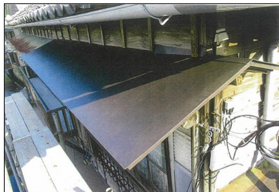
指定番号No.5土佐屋(屋根沈下修繕、庇等修繕) ※着工後
