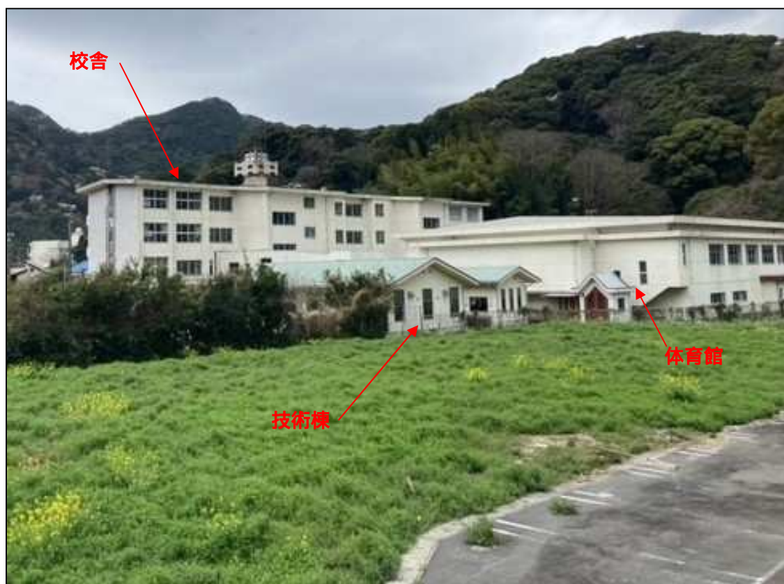
建設地北東側より撮影
