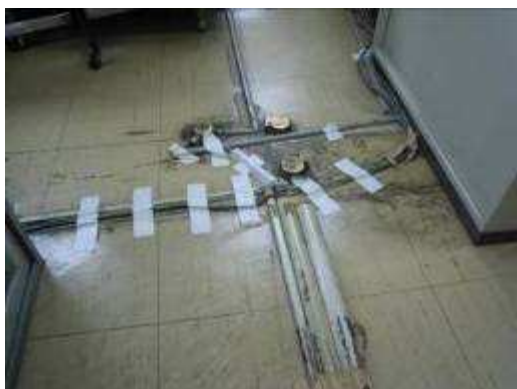
電源ケーブル等敷設状況
