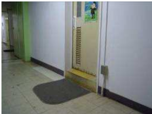
トイレ出入口の開き戸と段差
