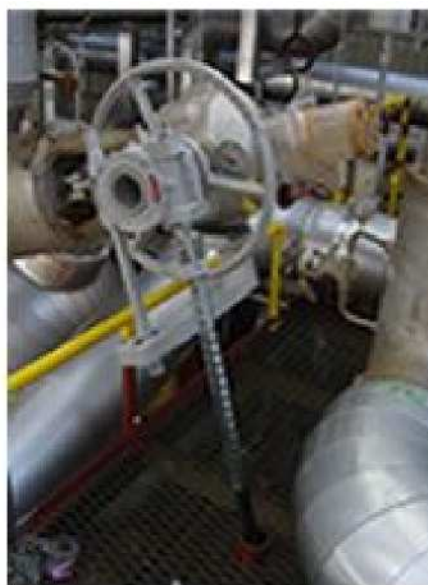
図 7.2 後付のハンドラー設備の事例
