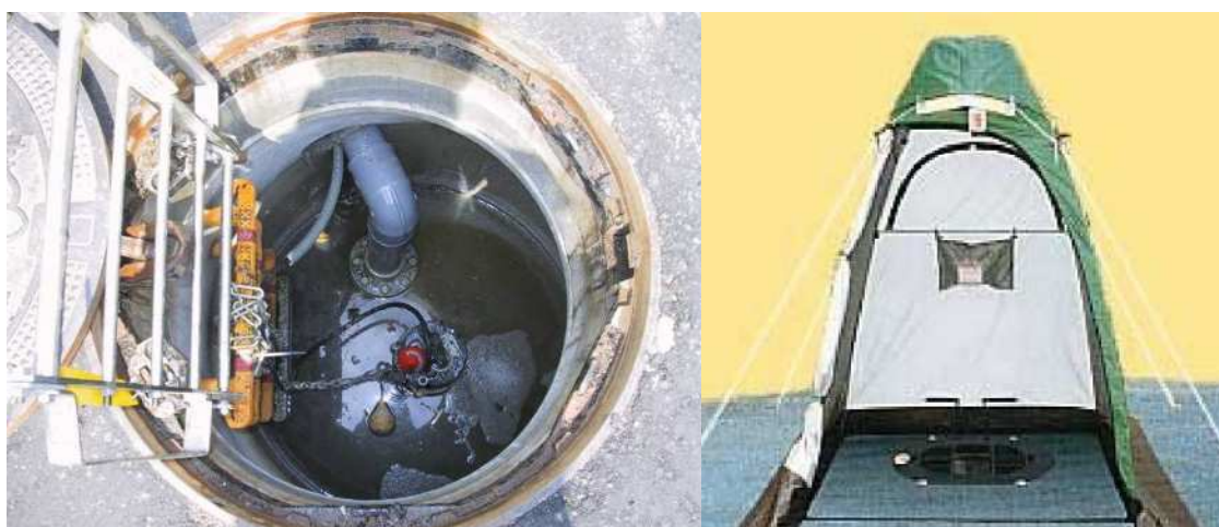
図 7.1 可搬式ポンプ（左図）及びマンホールトイレ（右図）の事例
