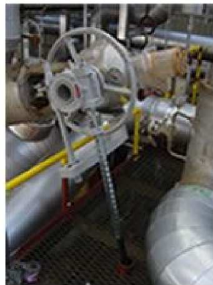
図 7-2 後付のハンドラー設備の事例
