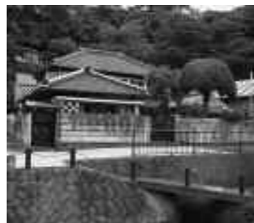
蔵の改修が進められる澤村邸
