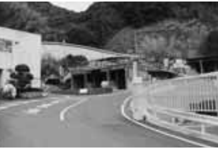
古紙類ストックヤードの建設を予定している清掃センター（敷根）
