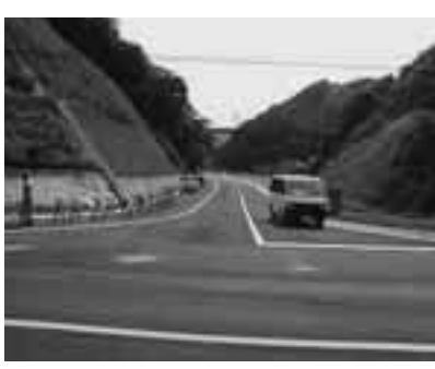
県道 河津下田線開通状況
