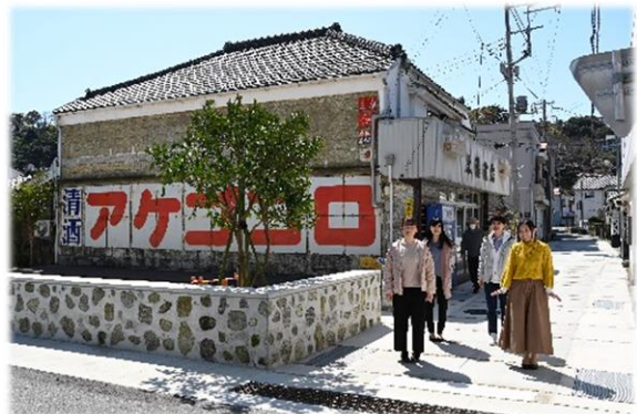
休憩施設として整備した「大工町プレイス」
