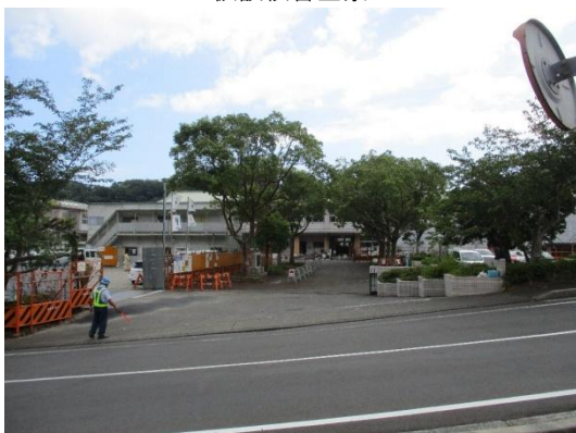
校門付近(仮囲い)
