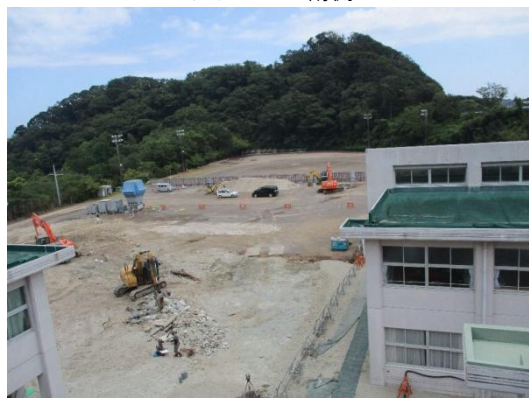
グラウンド付近(仮囲い)
