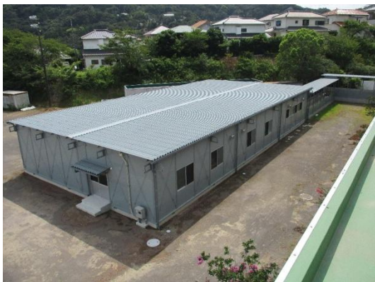
仮設校舎全景
