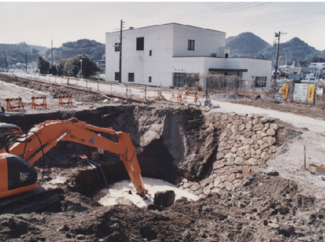
重機によって波除にかぶっていた土砂を取り除く作業
