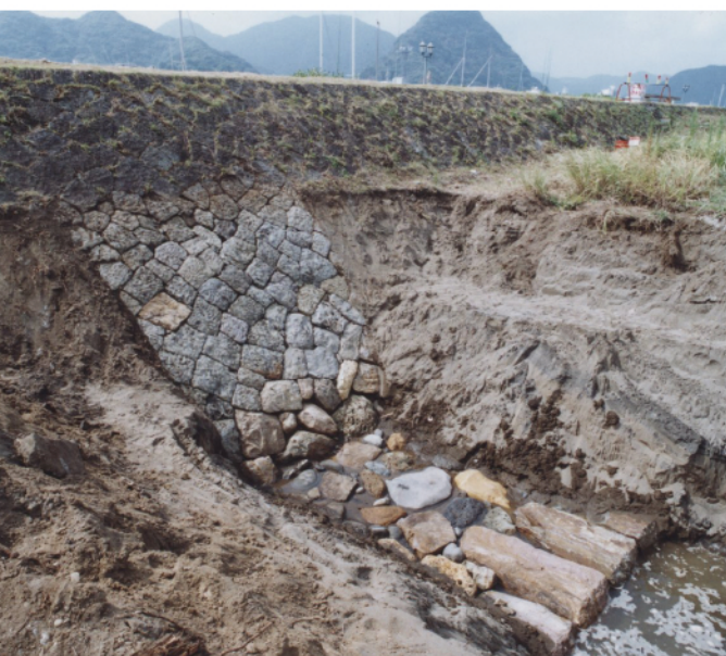
土砂を取り除いた後に出てきた波除の石積み
