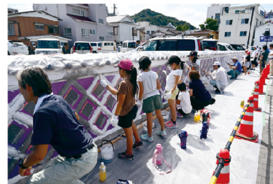
壁面に一列に並び、瓦部分（黒い壁）を養生テープで隠して、 白い部分をペンキで塗りました
