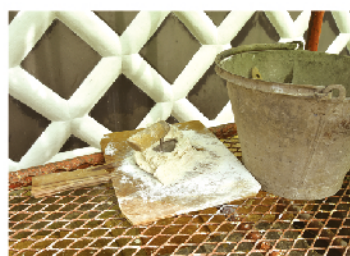
格子状に盛られた漆喰部分は 丁寧に職人が仕上げます
