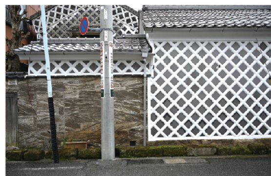
修繕後は耐久性のある材料を使用し、長期的な維持が期待できます
