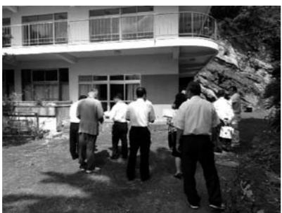
旧樋村邸耐震診断業務委託
